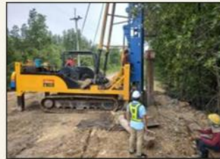
ตรวจสอบสภาพ/ซ่อมบำรุงเครื่องยนต์
