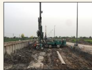
ก่อสร้างช่วงกลางวัน
